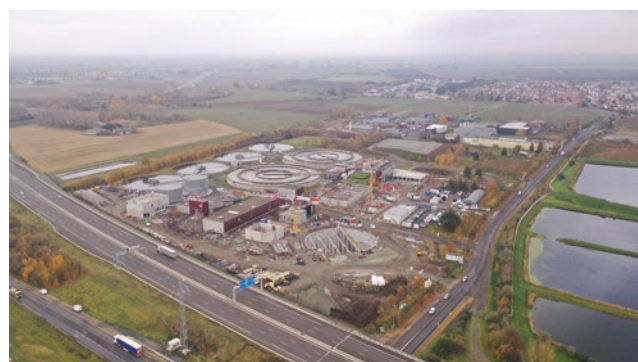
Travaux d'extension de la Station d'épuration des Trois Rivières
